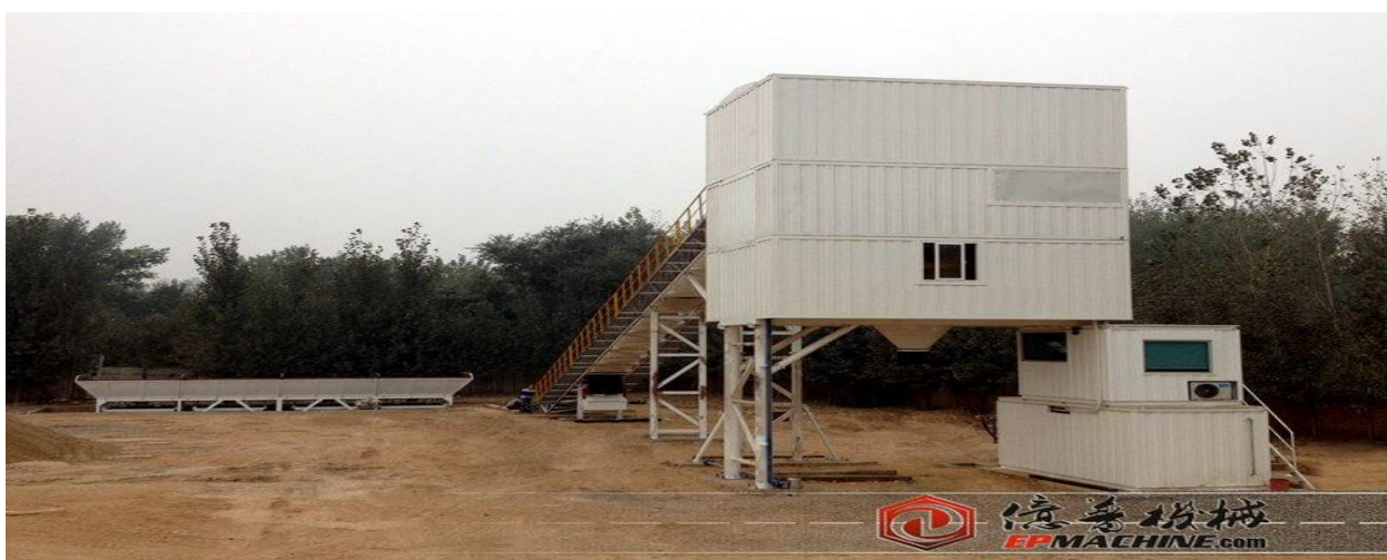
1.18 Сурет – Контейнерлік бетон завод
